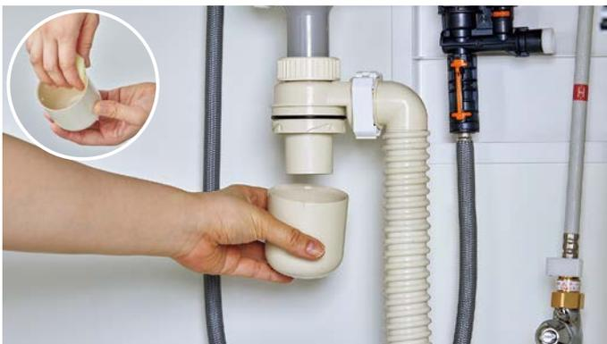
ボトルトラップ部が簡単に着脱でき、外れにくい構造。指輪などを流しても取り出しやすいです。また、排水の奥までお掃除できるので、なめらかな形状で排水口のお掃除を簡単にする新てまなし排水口と合わせ、定期的にお掃除いただくことで、ニオイやつまりの原因を低減できます。
